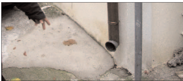
Alcune immagine eloquenti dello scarico dell'acqua piovana
